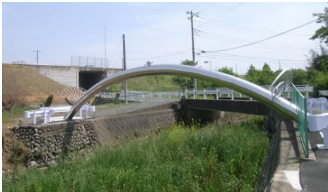
県内施工例 : 水道橋 (毛呂山町)
