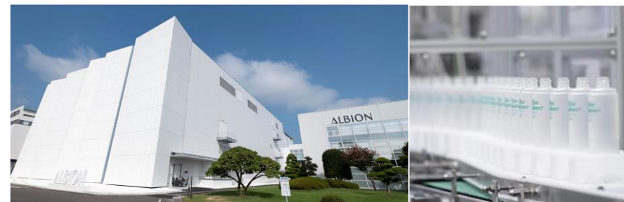
2020年 熊谷事業所 第一生産棟 竣工・稼働
