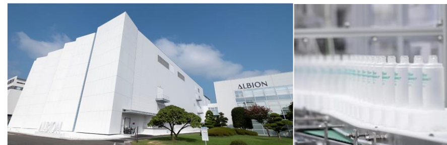
2020年 熊谷事業所 第一生産棟 竣工・稼働
