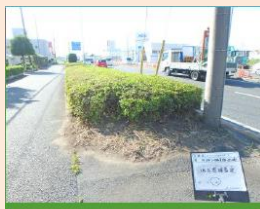
作業した後の状態
