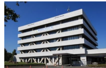
飯能市役所(耐震補強)
