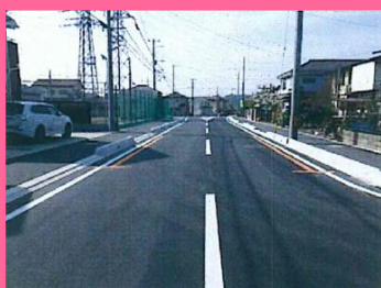
道路整備工事
