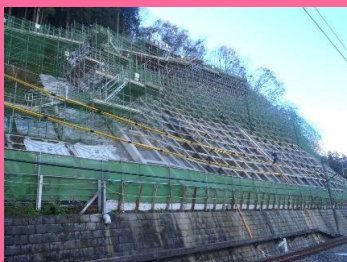
西武鉄道の修繕工事
