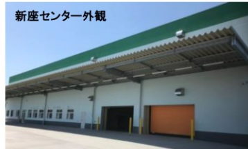
新座センター外観
