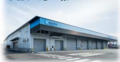
本社(上尾工場)
