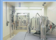
[埼玉工場 クリーンルーム]
