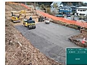
補強土壁作業
