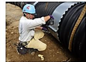
排水工接続作業
