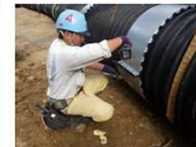
排水工接続作業
