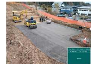
補強土壁作業
