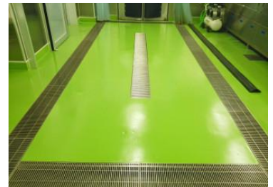
塗床工事施工例
