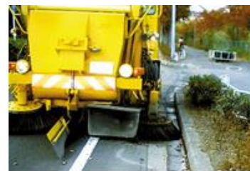
路面清掃の様子
