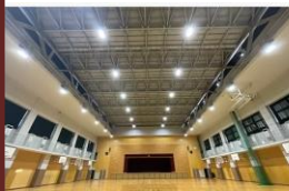
川越高校体育館照明改修工事 発注先：埼玉県
