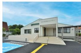
滑川町福祉センター建設工事 発注先：中里建設(株)
