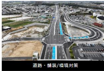
道路・舗装/環境対策
