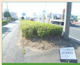
作業した後の状態
