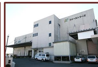
武蔵工場外観
