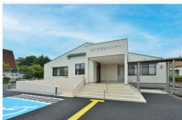
滑川町福祉センター建設工事 発注先:中量建設(株)
