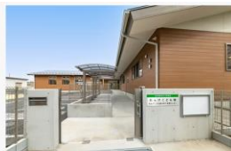
れんげこども園新築工事 発注先:初雁興業(株)
