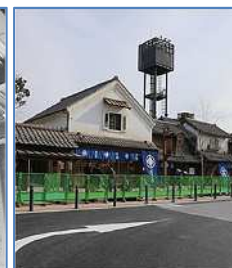
東北自動車道羽生PA(上り線) 空調換気設備
