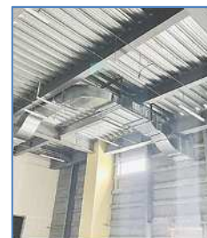
JA久喜物流倉庫 衛生、 消火、空調換気設備
