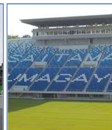
熊谷ラグビー場 既設スタンド・トイレ改修工事
