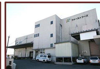
武蔵工場外観
