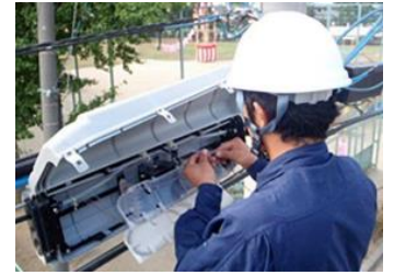
光やLANなど通信工事にも対応
