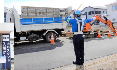
交通誘導警備
