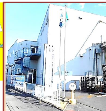
東京支店外観
