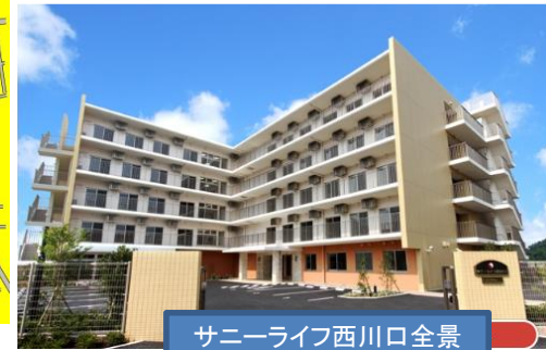
サニーライフ西川口全景
