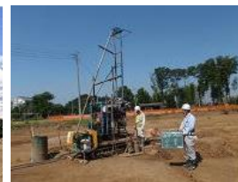
ボーリング調査
