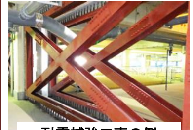
耐震補強工事例
