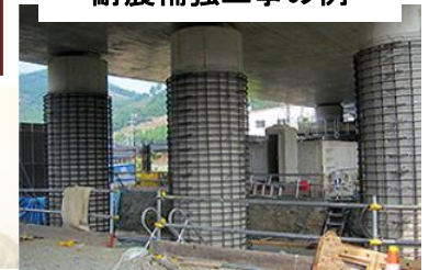
耐震補強工事例
