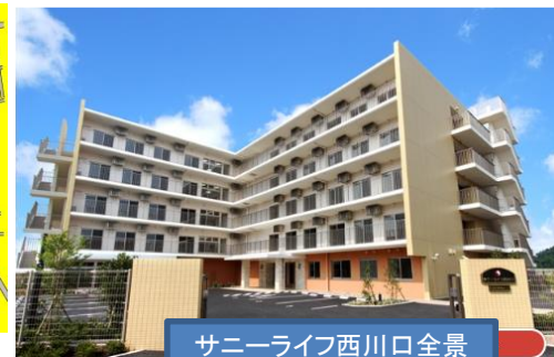
サニーライフ西川口全景
